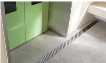
①エレベーター前など施工個所に高さが浅い場所にも施工可能。
