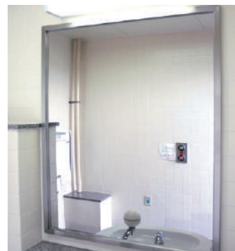
有料道路料金所トイレ (LKSS特注)
