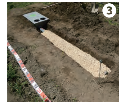
3 トレンチパイプの上に浸透促進剤をまんべんなく入れます。
