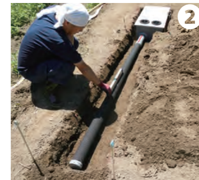
2 便槽の穴とトレンチパイプの溝を掘り、設置し、つなぎます。トレンチパイプが水平になっているか確認します。
