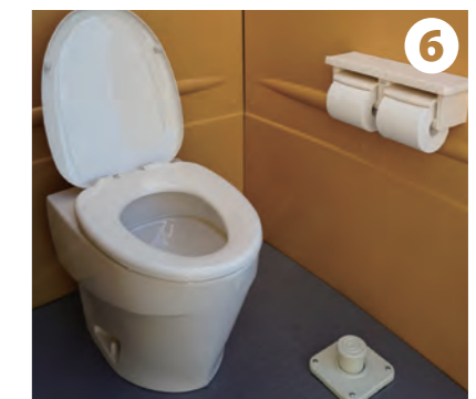
6 洋式便器を取り付けます。次に足踏みポンプとペーパーホルダーを取り付けます。
