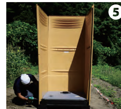
5 床パネル、壁パネル、屋根の順でトイレハウスを組み立てます。
