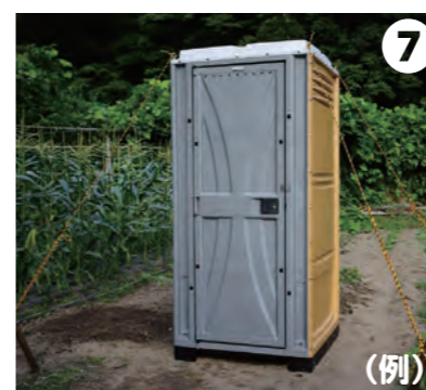
7 完成したトイレハウスが倒れないようにロープ等で固定します。※ロープはついておりません。現場でご用意してください。
